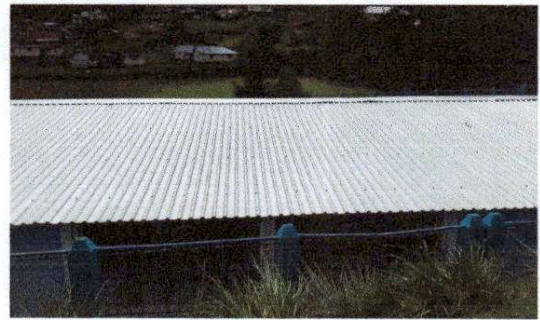
Foto 4: Sustitucion de capote y elementos de fijación
