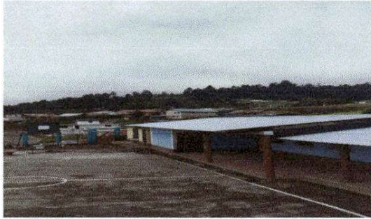
Foto1: sustitucion de lamina, por lamina troquelada aluzinc calibre 26
