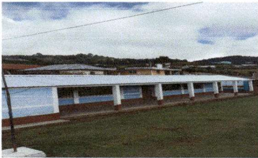
Foto 3: sustitucion de lamina por lamina troquelada aluzinc calibre 26
