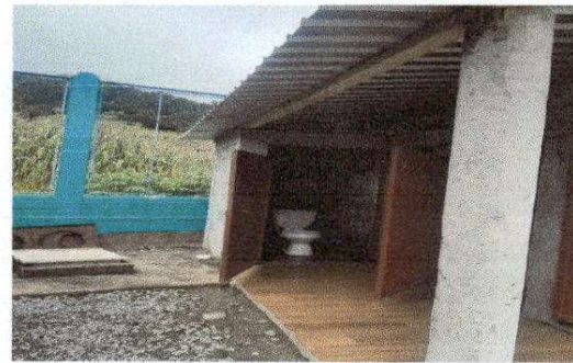
Foto 6: sustitucion de inodoro
