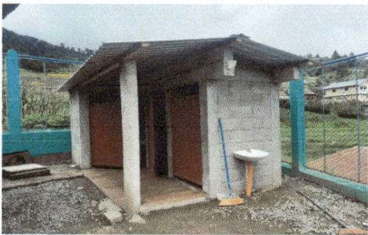
Foto 5: sustitucion de piso
